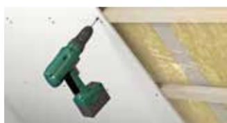
... oder auf die Holzunterkonstruktion mit eingelegter Dämmung geschraubt.
