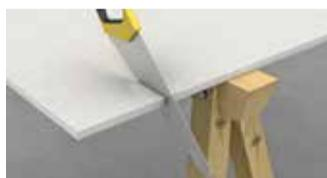
... oder alternativ mit Fuchsschwanz, Stich- oder Kreissäge schneiden.
