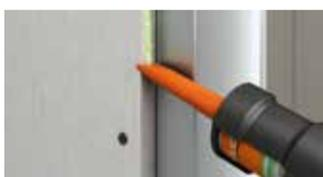
Verarbeitung 1: Die **fermacell** Gipsfaser-Platten präzise mit **fermacell** Fugenkleber auf Stoß kleben ...
