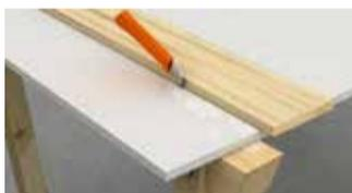
Die Platte mit dem **fermacell** Plattenreißer entlang einer Latte anritzen ...
